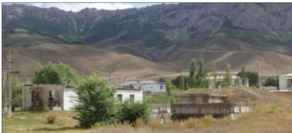
Сүрөт 1-13 «Батыш» суу алгычынын экинчи көтөрүлүштөгү насостук станциясынын жана резервуарынын сырткы көрүнүшү.
