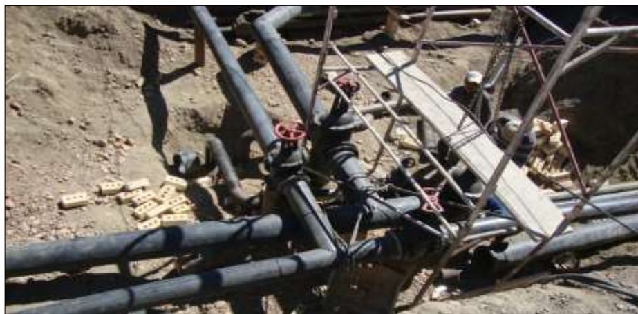
Сүрөт 1-6 «Ак-Бечел» суу алгычындагы диаметрлери 325 жана 219 мм пластикалык водоводтордун –жаңы түтүктөрдүн эки тармагынын (таза суу резервуарларына кирген жактагы) үстүнкү бөлүгүнүн көрүнүшү.
