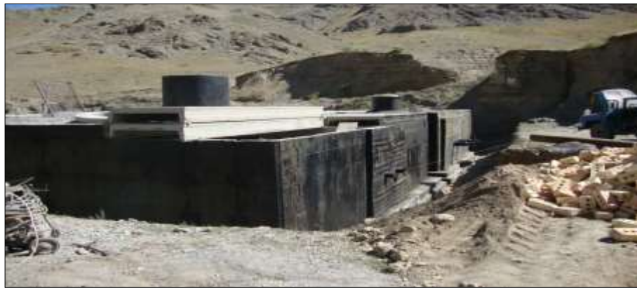
Сүрөт 1-5 «Ак-Бечел» суу алгычындагы, ар бири 1500 м 3 болгон, эки таза суу резервуарынын (ТСП) сырткы көрүнүшү.
