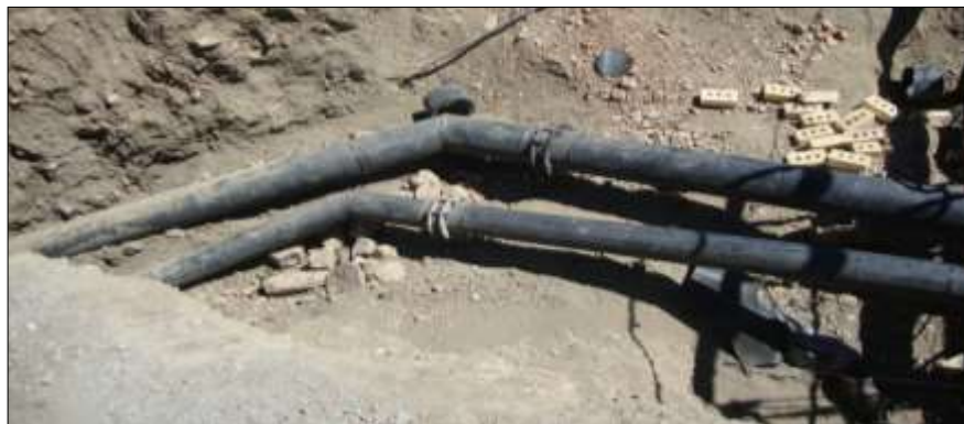
Сүрөт 1-7 «Ак-Бечел» суу алгычындагы диаметрлери 325 жана 219 мм пластикалык водоводтордун—жаңы түтүктөрдүн эки тармагынын экинчи көрүнүшү.
