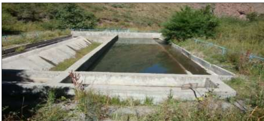
Сүрөт 1-9 «Ак-Бечел» суу алгычынын тундугучтары (август 2012 ж.).
