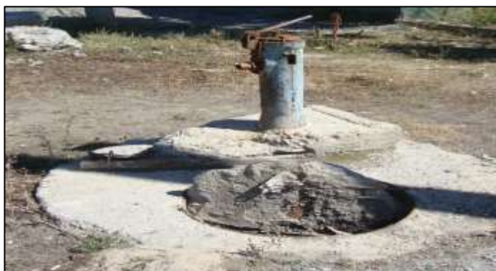
Сүрөт 1-2 Иштен чыккан колонкалардын бири.
