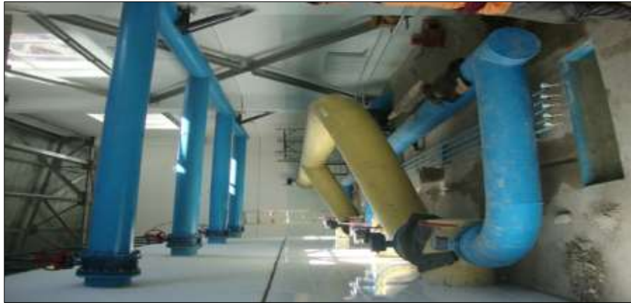
Сүрөт 1-4 «Ак-Бечел» суу алгычынын ылдамдатылган фильтрлеринин жаңы имаратынын ичиндеги түтүк өткөргүчтүн бөлүгү.
